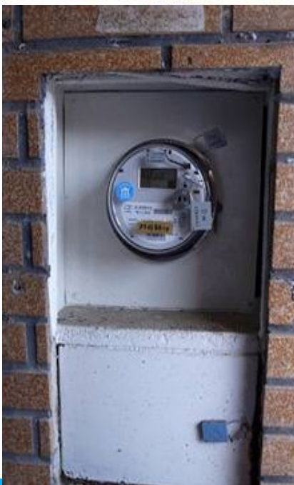
地下室入口被封死 只有這塊可活動
