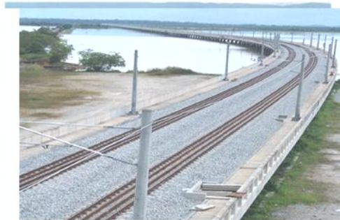
"Marine Viaduct" Bukit Merah
